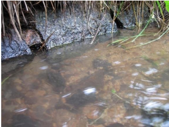
Abbildung 2 Lücken im Steinsatz (PS m1)
