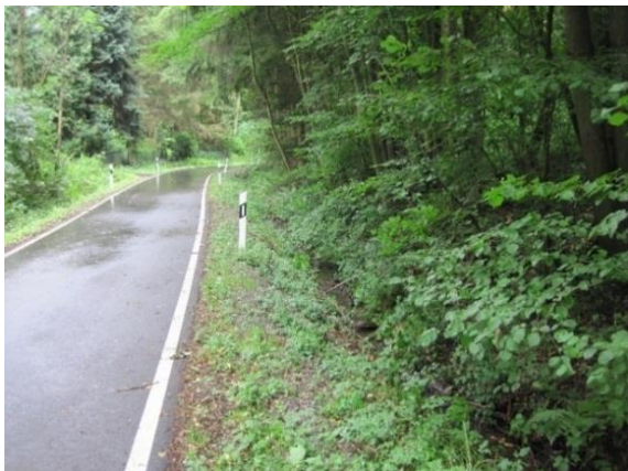
Abbildung 4 linker Quellast unterhalb Rohrbach (PS m5)
