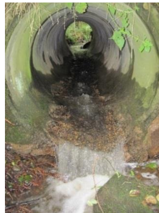
Abbildung 5 unpassierbare Rohrdurchlässe (PS m2-m11)
